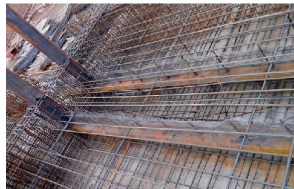
防水混凝土后浇带施工缝留设
