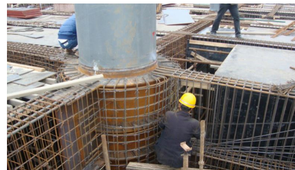
钢梁与钢柱节点施工
