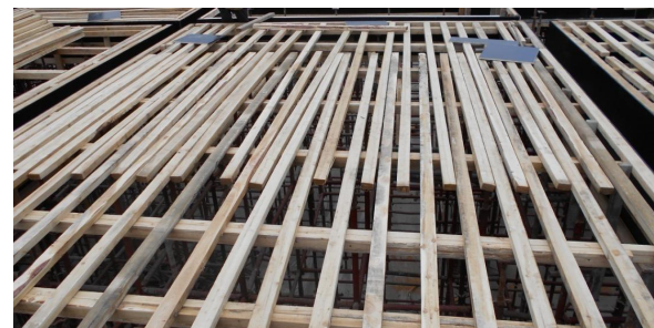
楼板模板安装
