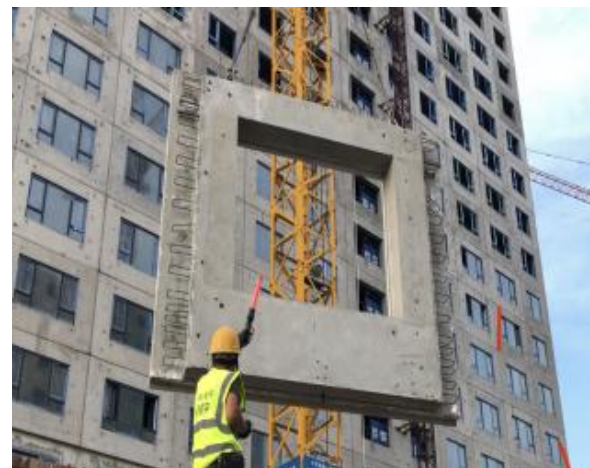
预制墙板吊装
