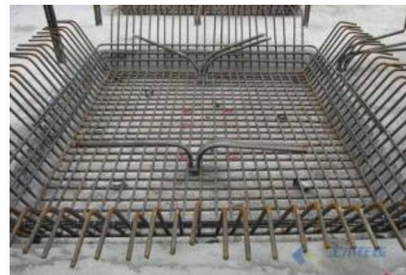
抗浮锚杆钢筋穿插
