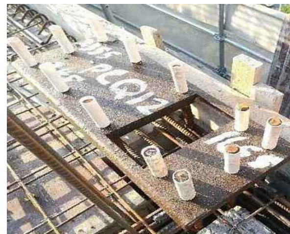
预制柱钢筋定位
