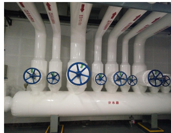
空调水系统阀门安装
