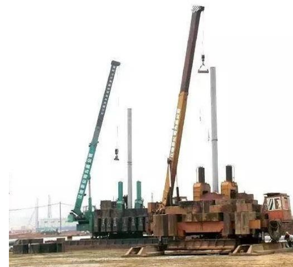
静压管桩施工
