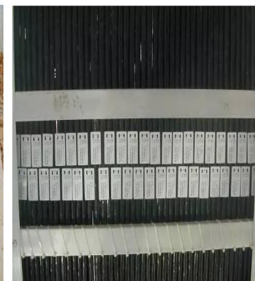
电缆敷设及标志牌安装
