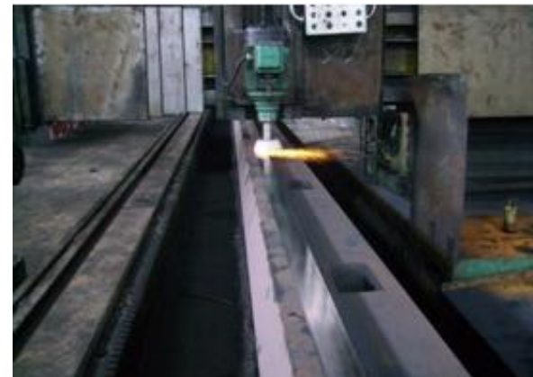
刨边机开坡口施工
