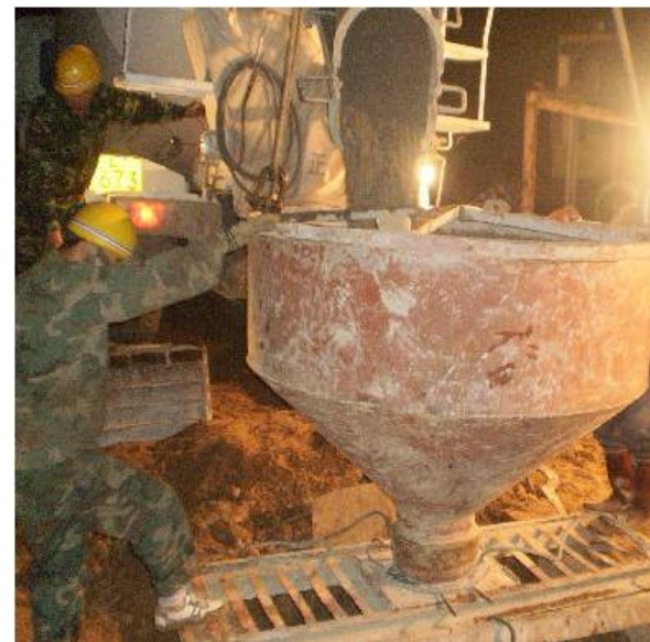
灌注桩混凝土施工
