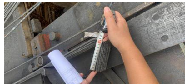
箍筋钢筋加工
