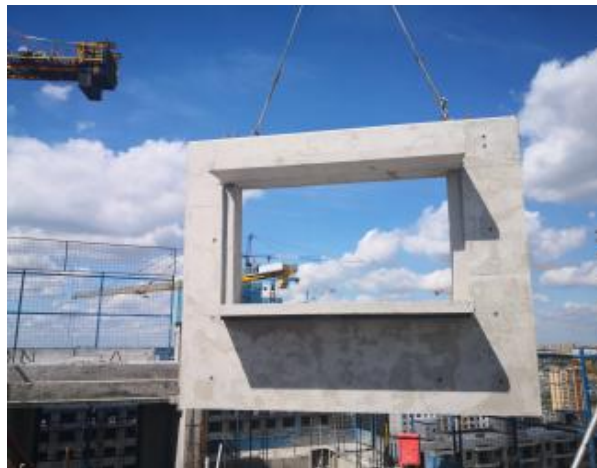
异形墙板落位
