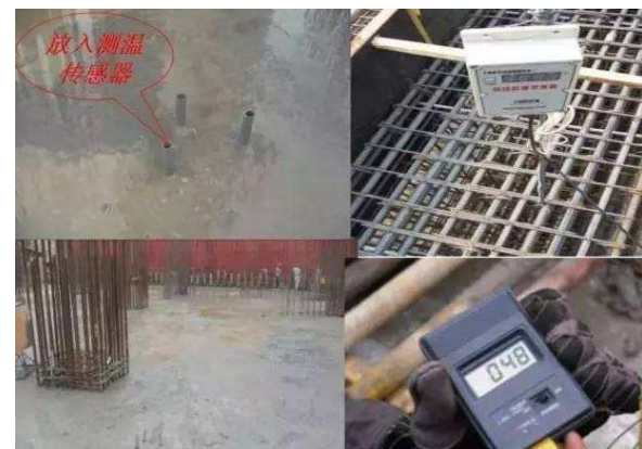
大体积混凝土测温传感器
