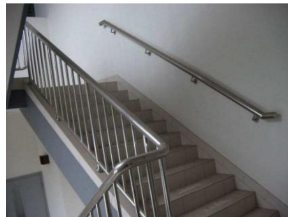
室内扶手安装
