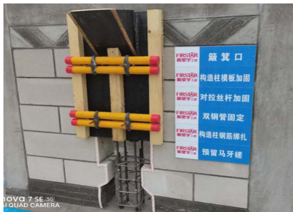
构造柱钢筋模板安装样板
