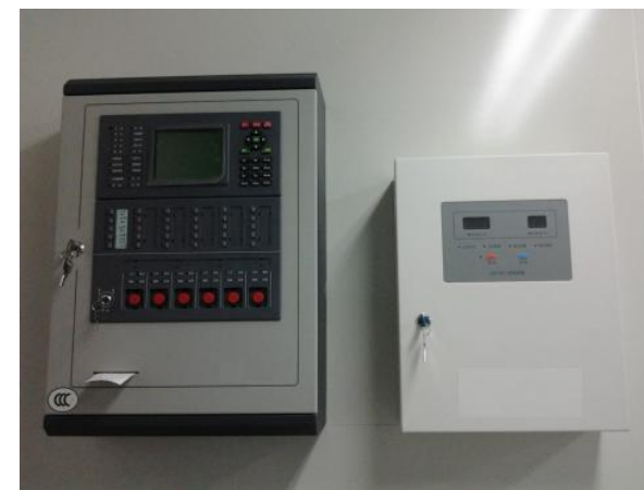
消防控制设备安装
