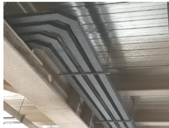
消防金属线槽安装
