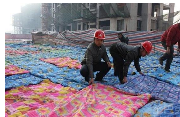
冬期施工保温养护
