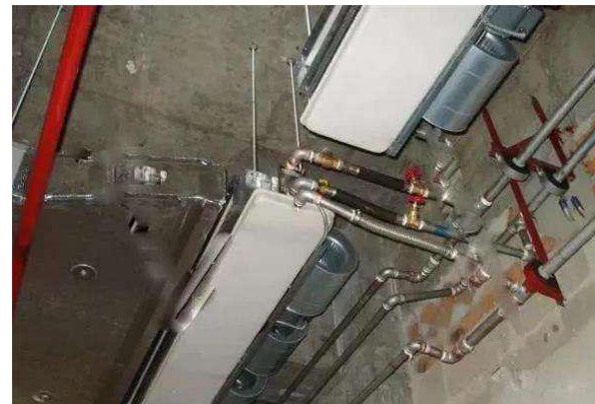
风机盘管安装
