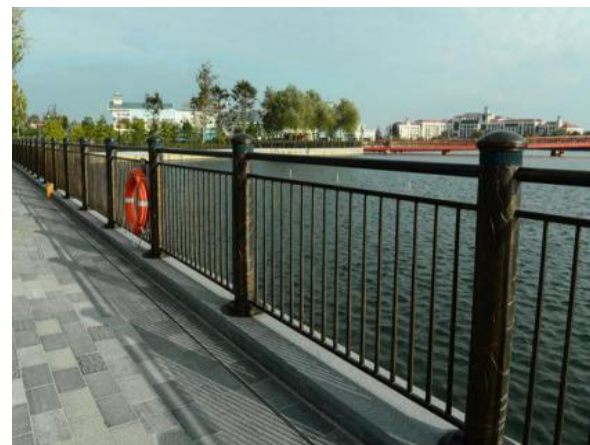
室外栏杆安装
