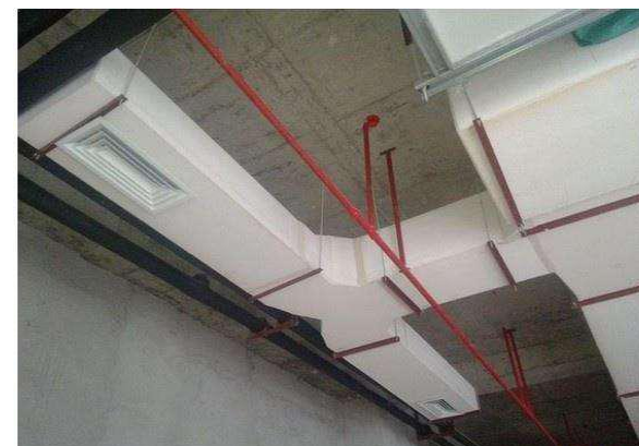
风管支吊架安装
