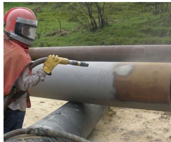
管道喷砂除锈施工
