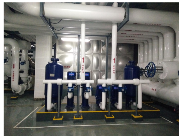
空调补水泵安装
