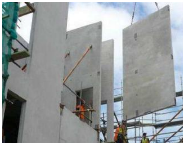
预制外挂板吊装
