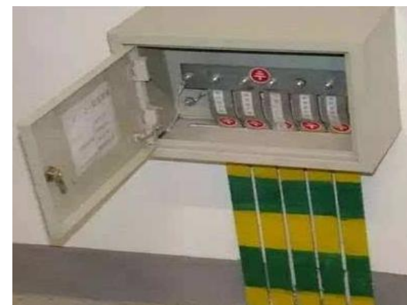
明装等电位安装
