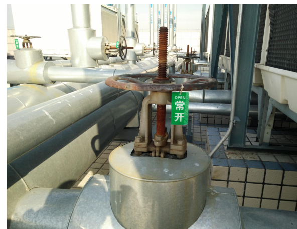
空调室外阀门带镀锌板保护层及标识
