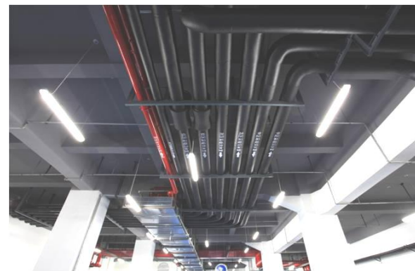
空调管道橡塑保温
