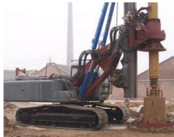
旋挖成孔灌注桩施工
