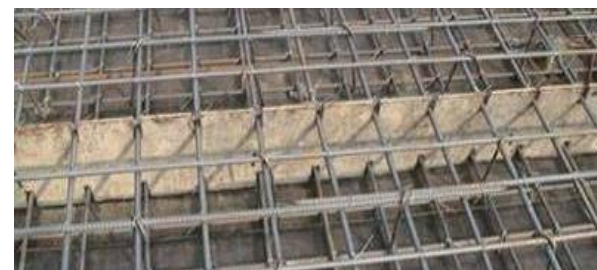
板施工缝留设
