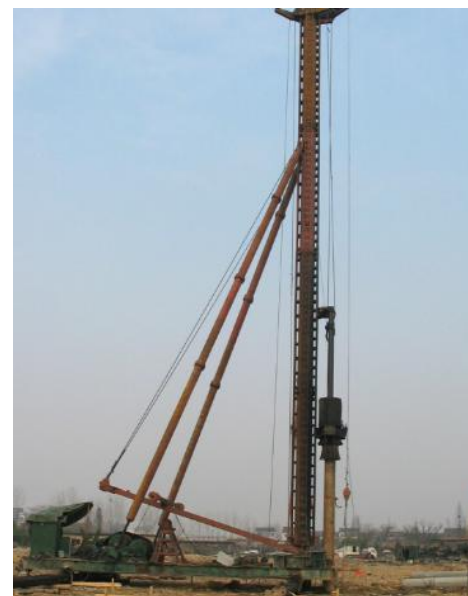
高压旋喷桩施工
