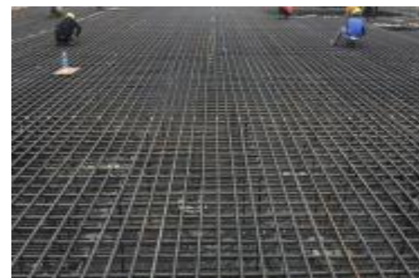
结构板钢筋安装
