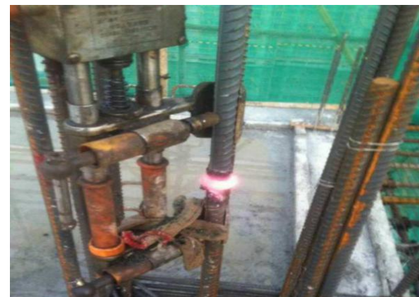
电渣压力焊施工
