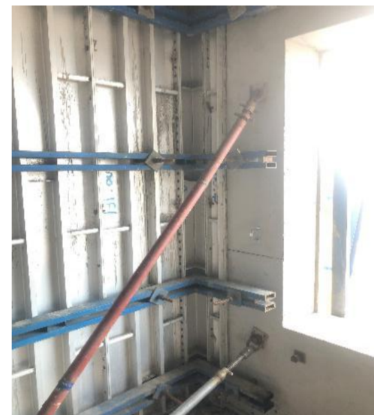
后浇段模板安装
