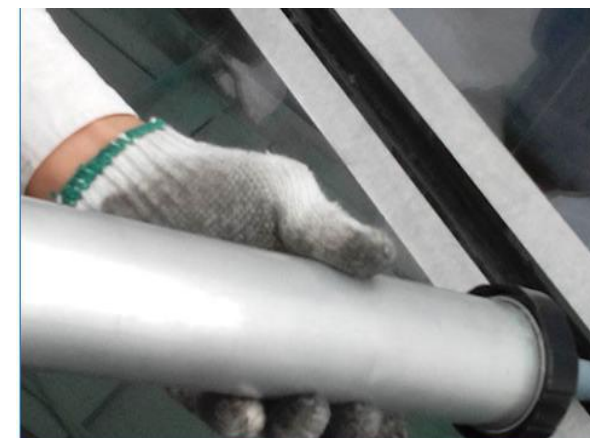
幕墙密封胶施工
