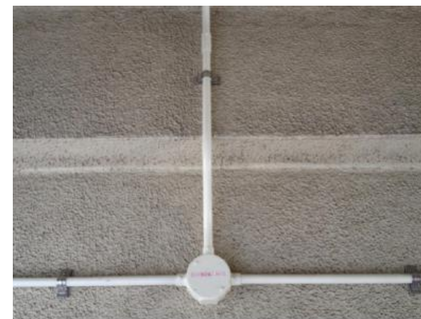
明配消防管线安装
