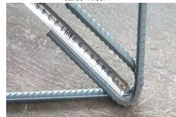
箍筋加工成型
