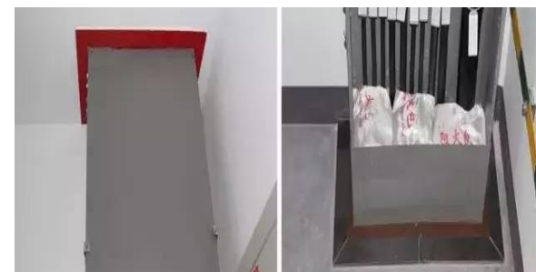
梯架、托盘和槽盒安装防火封堵
