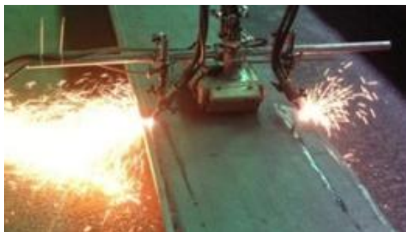
气割机开坡口施工
