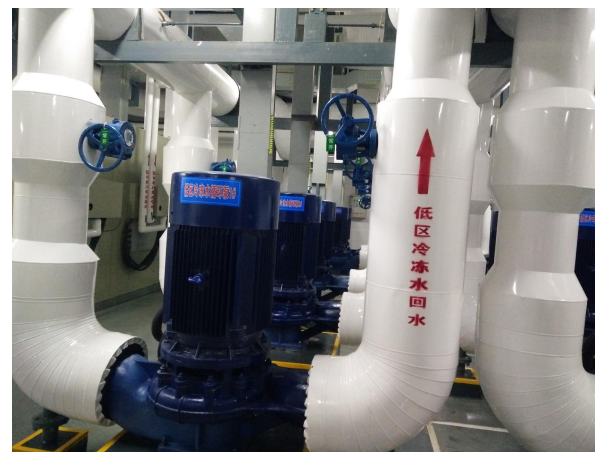
空调冷冻水循环泵安装
