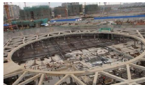
钢筋混凝土内支撑（环撑）
