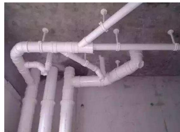
U-PVC排水管安装
