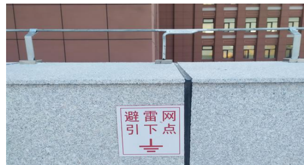
避雷引下点标识安装
