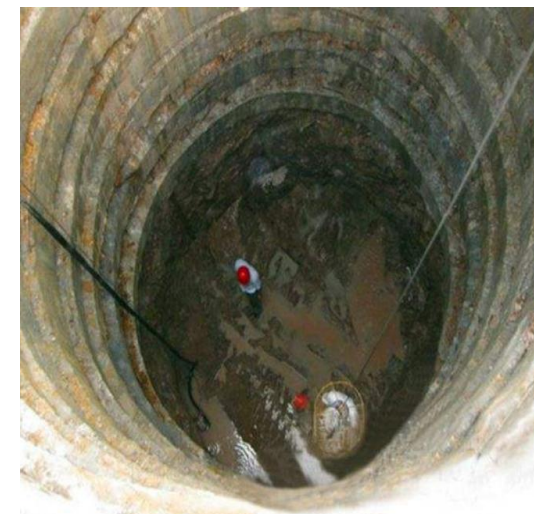
人工挖孔桩成孔逐层循环作业
