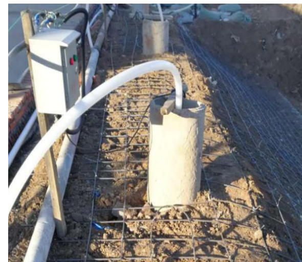
井点降水施工
