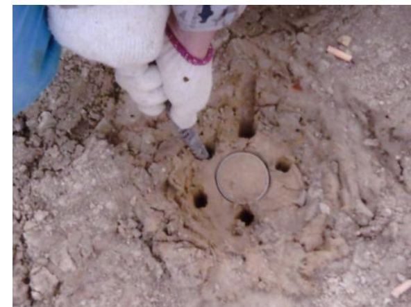
土方压实度检测取样
