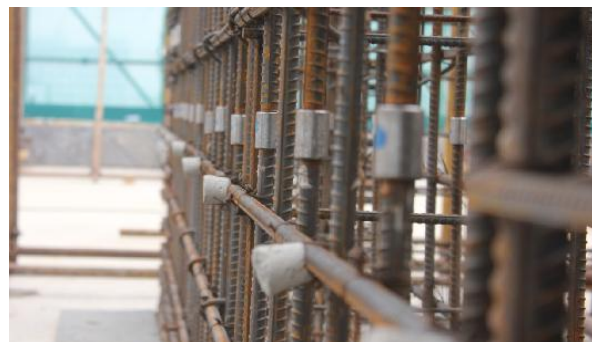
剪力墙钢筋套筒安装效果
