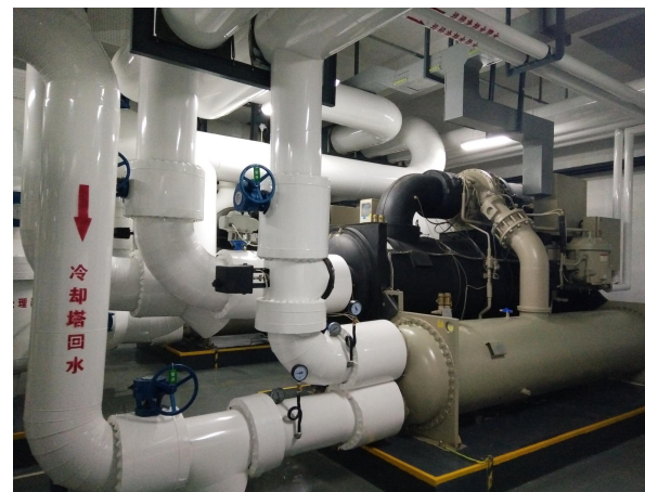
冷水机组安装
