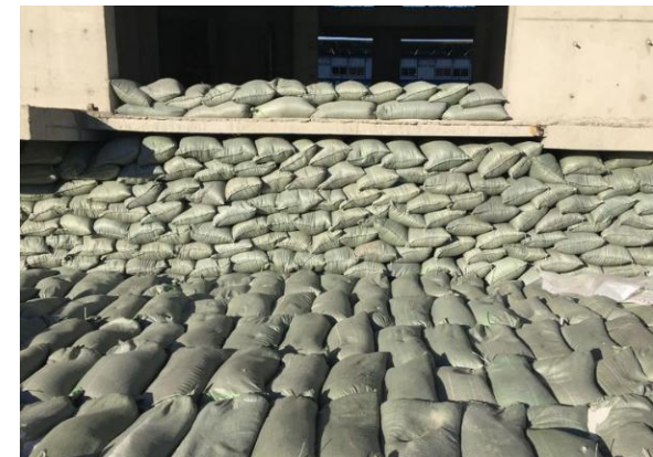
夹层外墙采用珍珠岩码垛墙保温
