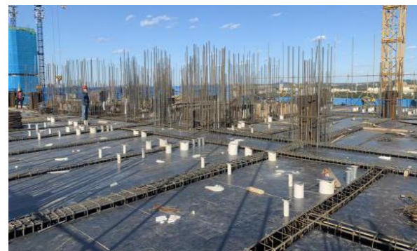
结构梁钢筋安装成型
