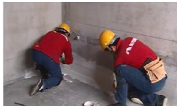
墙面防水涂刷
