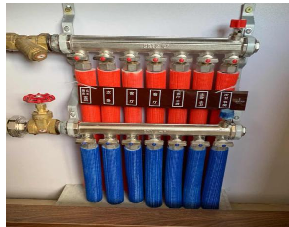
分、集水器安装
