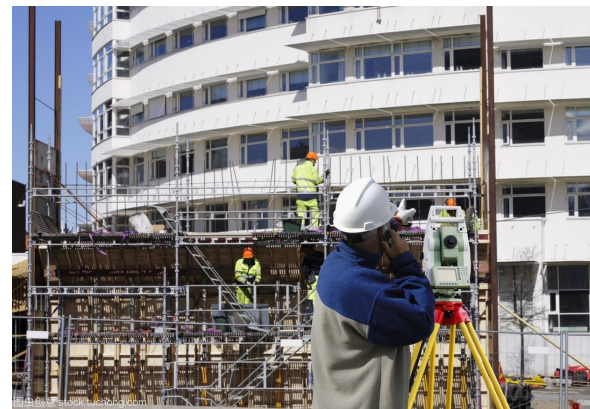
结构整体测量
