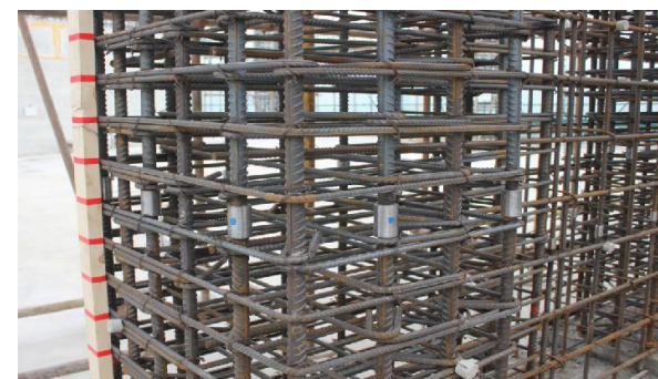
水平钢筋间距控制
