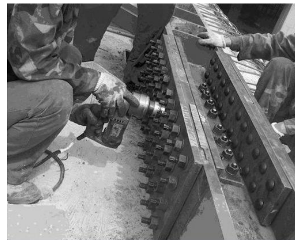
高强螺栓施工
