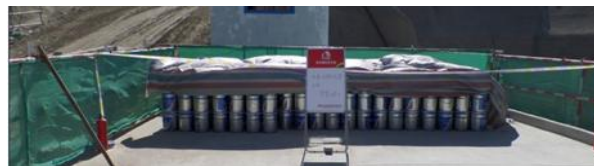
防水涂料现场存放
