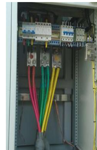
电缆终端头安装
