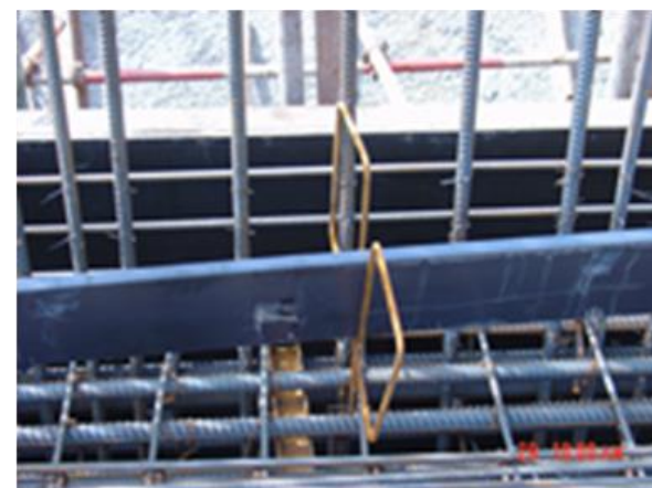
筏板混凝土导墙止水板安装
