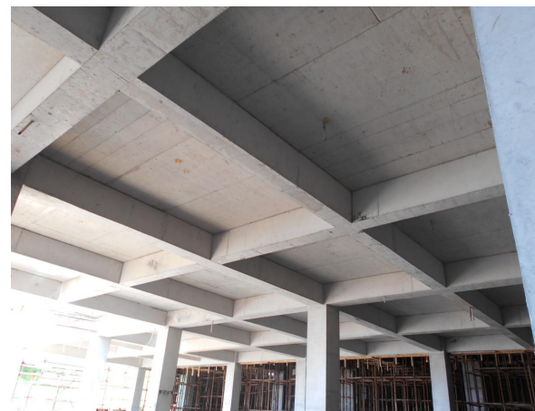
梁、板结构成型效果
