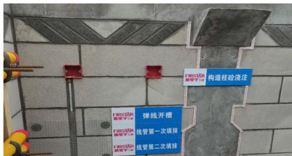
构造柱浇筑样板
