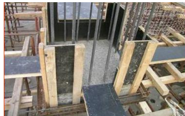
梁、柱交接处柱模板安装
