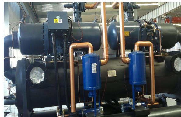
冷水机组安装
