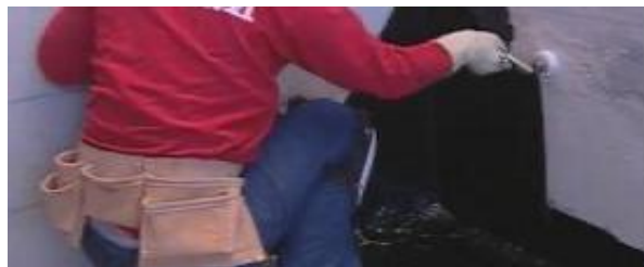
涂料防水施工
