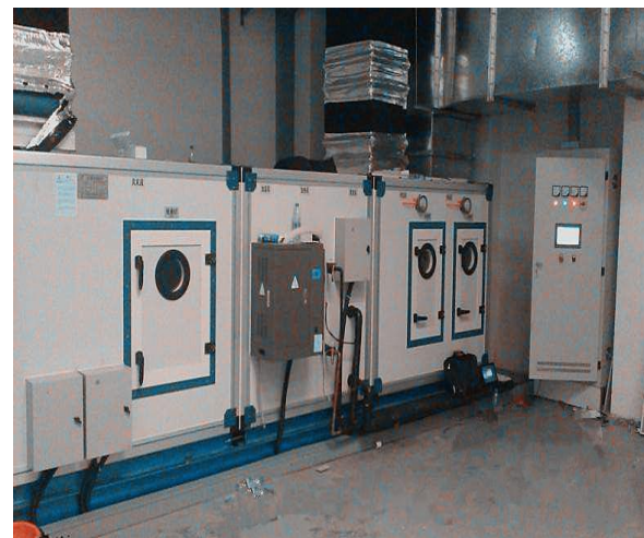
空调机组试运行
