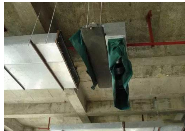
风机盘管安装
