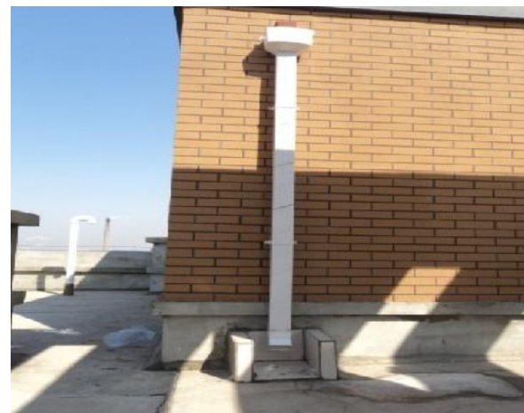
外墙雨水管安装
