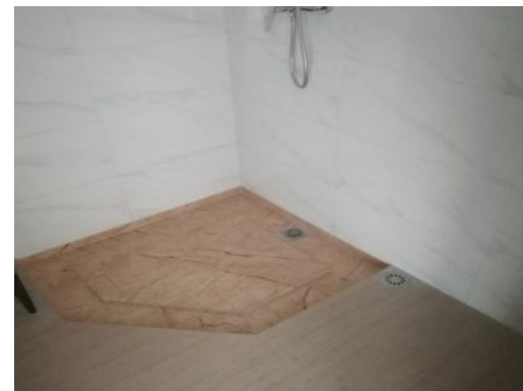
淋浴间处铺贴
