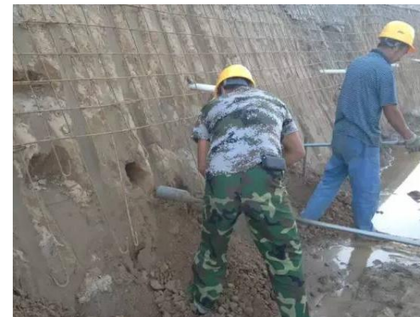
土钉定位成孔施工
