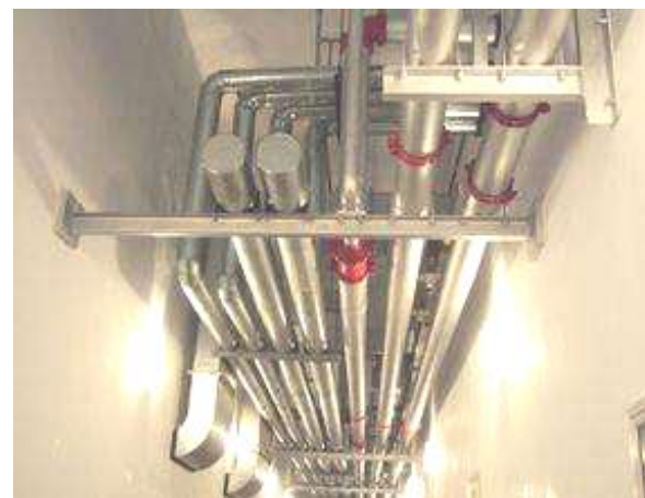
空调管道与消防管道共用支架安装
