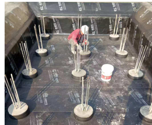
桩头防水施工
