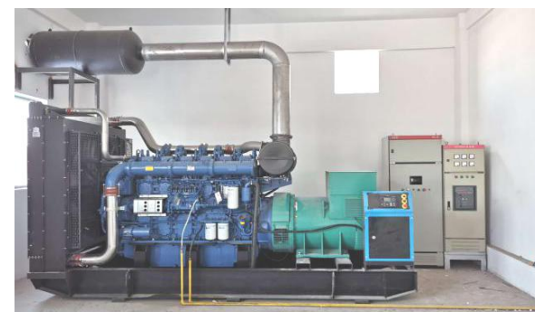
柴油发电机安装
