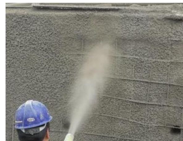
土钉墙喷射混凝土施工
