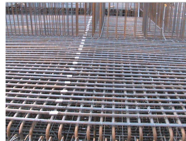
筏板基础钢筋绑扎及连接
