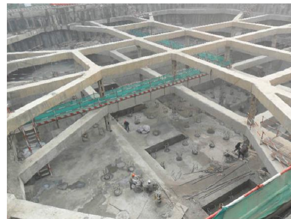
钢筋混凝土内支撑（角撑）
