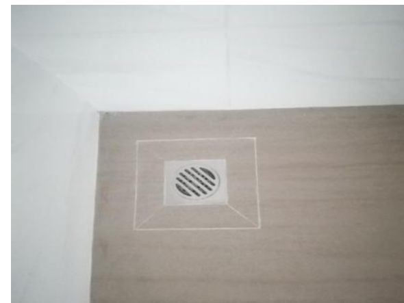
排水地漏铺贴
