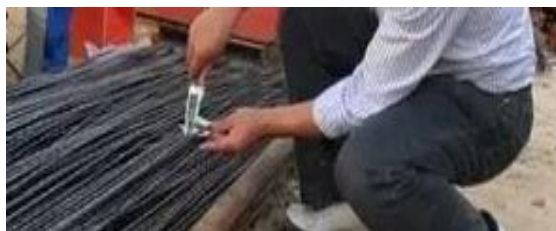
钢筋进场检验
