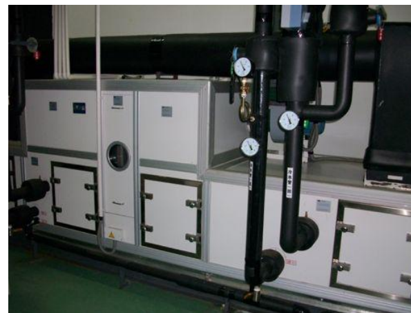
组合式空调机组安装
