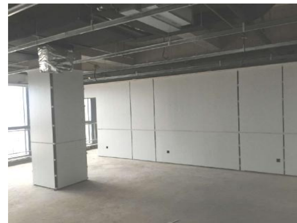
内墙饰面板安装
