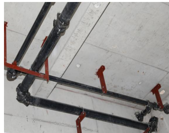
铸铁排水管安装
