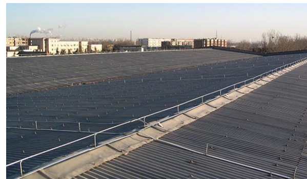
屋面避雷网安装
