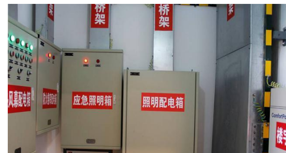
强电井内安装
