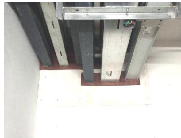
消防线槽穿墙防火封堵
