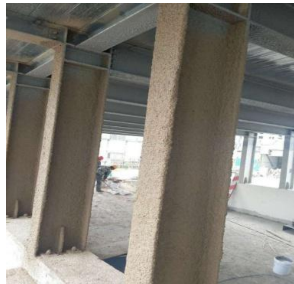
防火涂料施工
