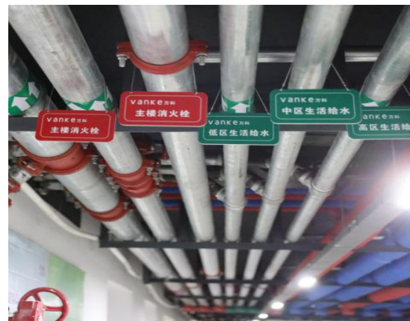
给水管道安装
