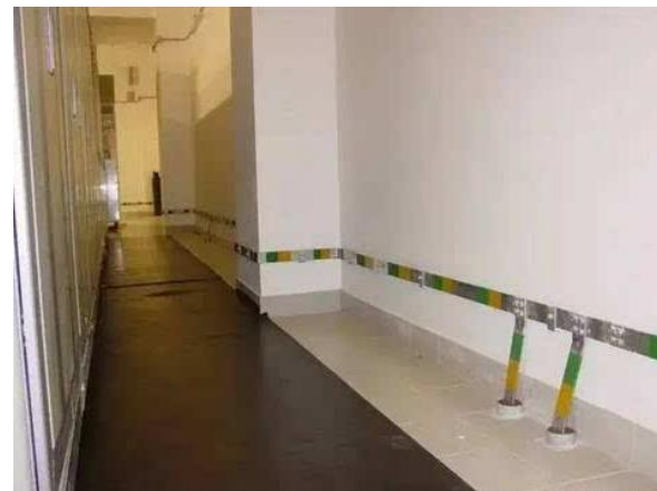
接地干线安装
