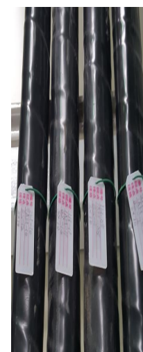
电缆敷设及标 志牌安装
