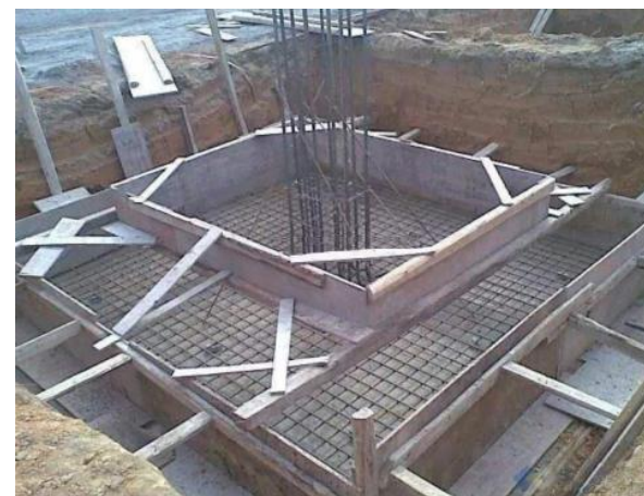
独立基础模板安装
