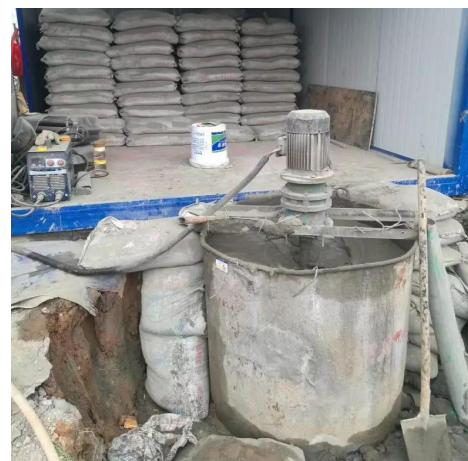
高压旋喷桩制浆
