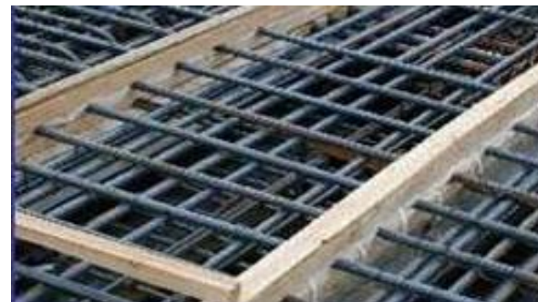
现浇板后浇带留置
