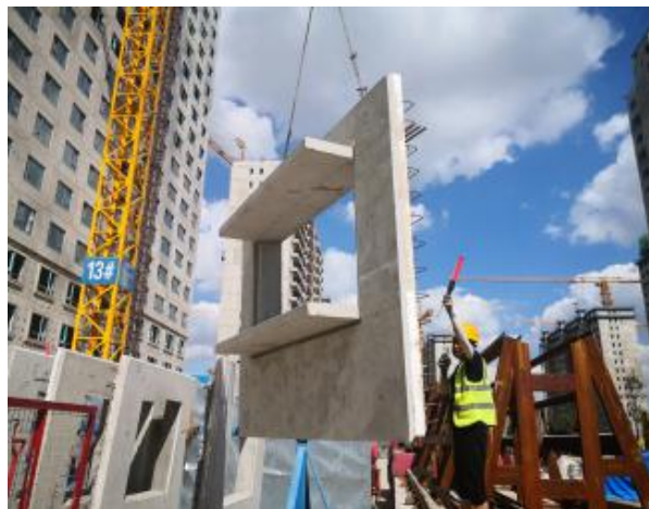
异形墙板吊装
