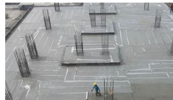
筏板基础混凝土浇筑及养护
