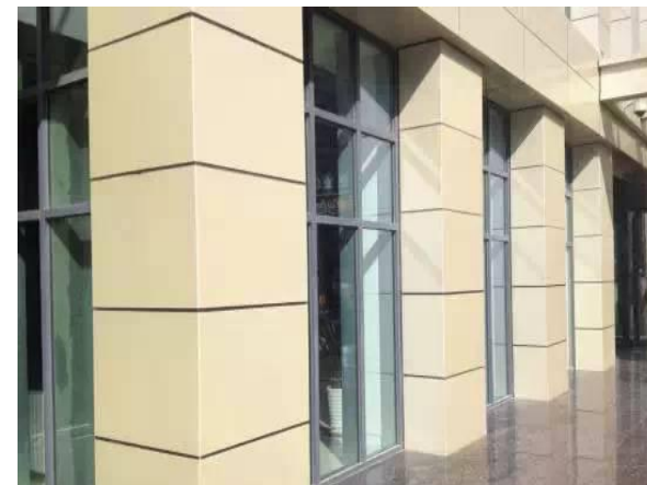
外墙饰面板安装
