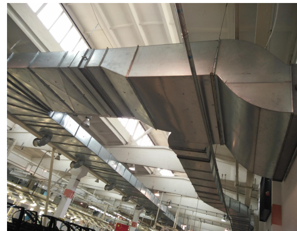
共板法兰风管安装
