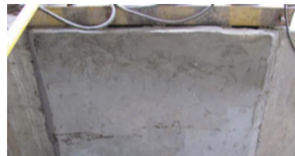
地下室后浇带预制盖板
