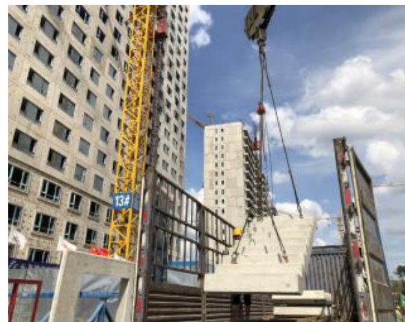
预制楼梯吊装
