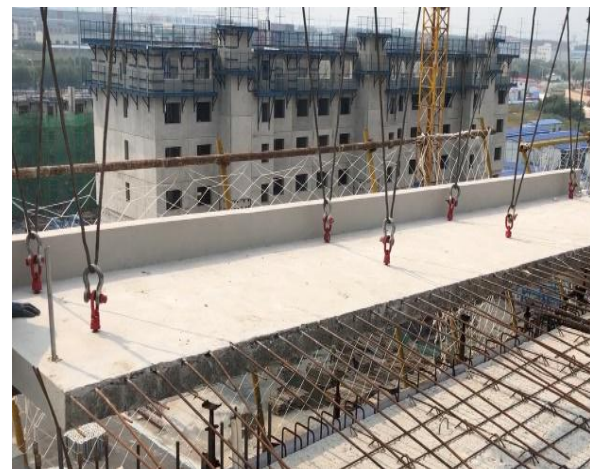
预制阳台板吊装
