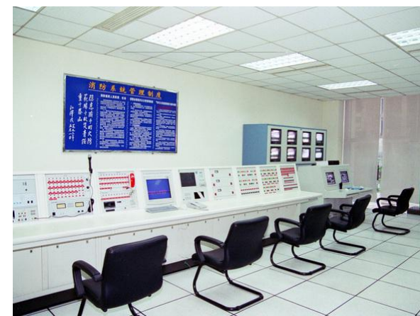
消防主机安装
