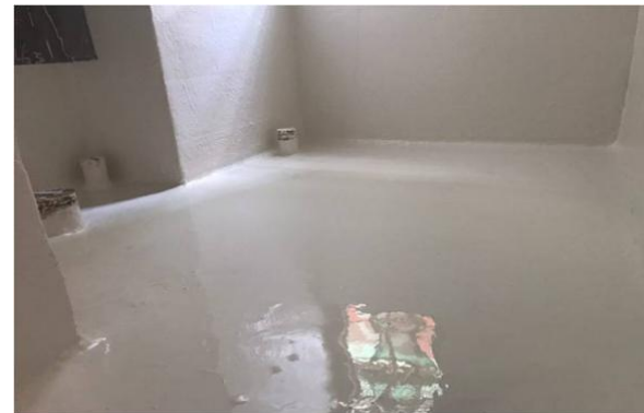
防水隔离层蓄水试验
