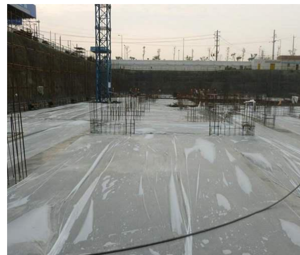
混凝土覆盖养护
