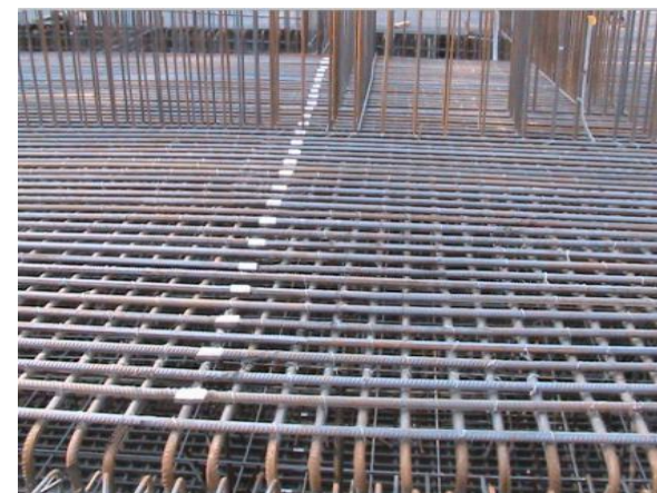
结构板钢筋安装效果
