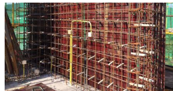
剪力墙墙钢筋安装
