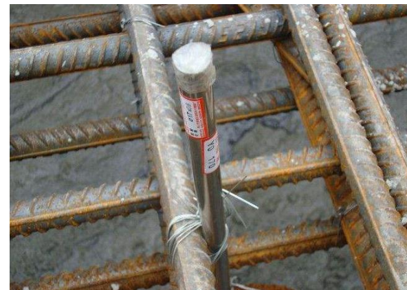
大体积混凝土测温点放置
