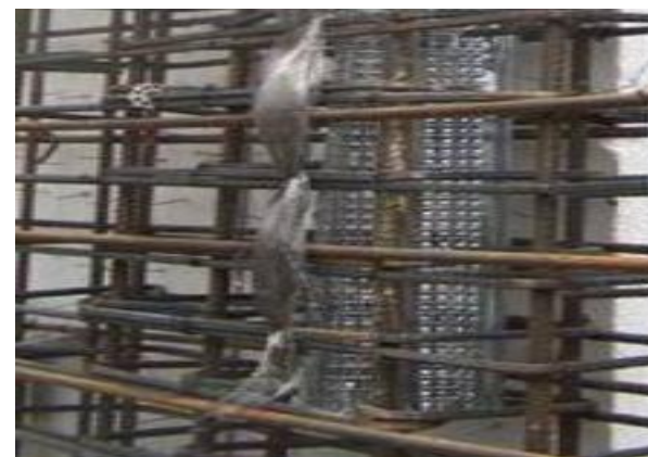
剪力墙施工缝留设
