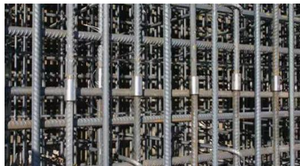
剪力墙钢筋套筒安装效果
