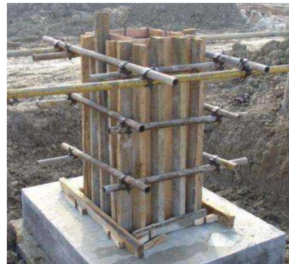
基础短柱模板安装
