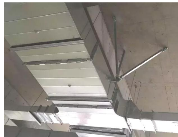
通风管道支吊架（含抗震支架）
