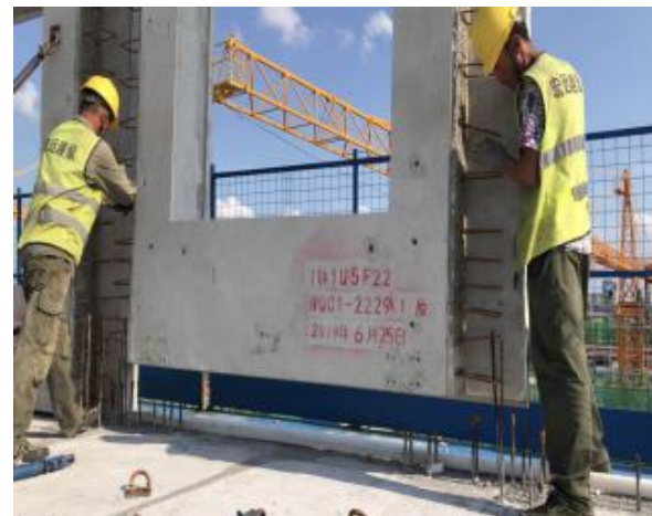
预制墙板落位
