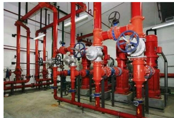
管道防腐效果图
