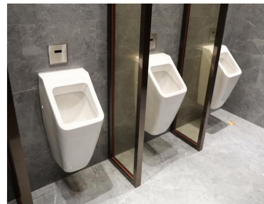
感应式冲洗阀壁挂式小便器
