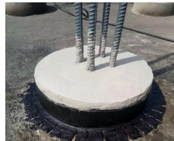
桩头防水附加层施工
