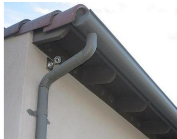
檐沟雨水管安装
