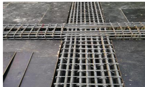
结构梁钢筋安装
