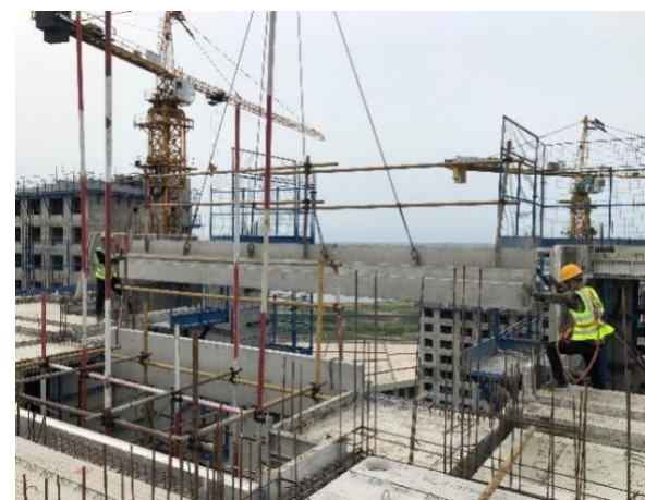
预制叠合梁安装
