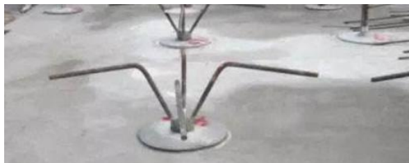
抗浮锚杆桩头
