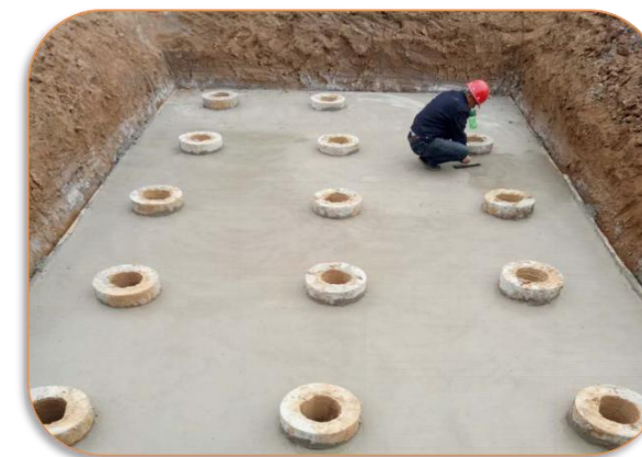
静压桩截桩完成
