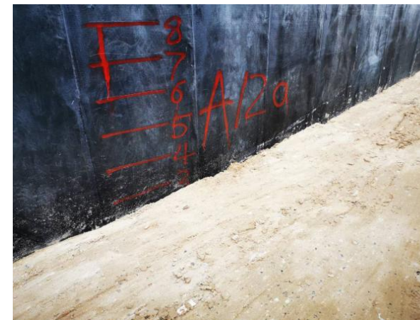
土方回填分层画线压实
