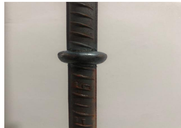
电渣压力焊焊包
