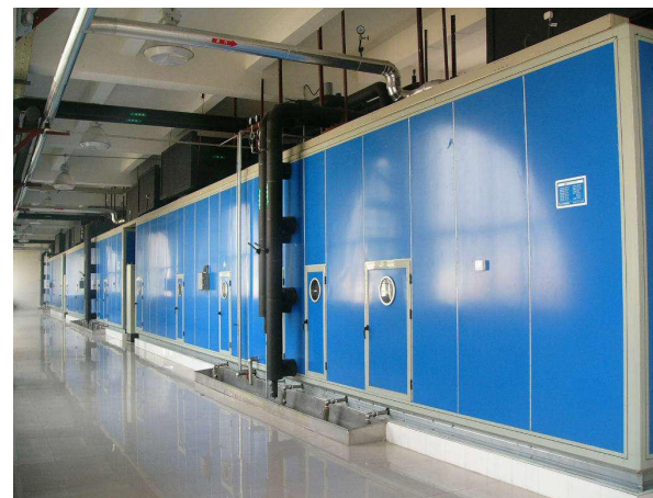
组合式空调机组安装
