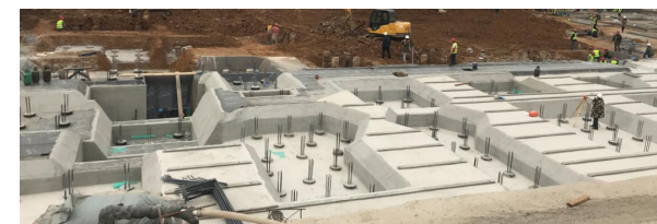
筏板基础防水保护层施工
