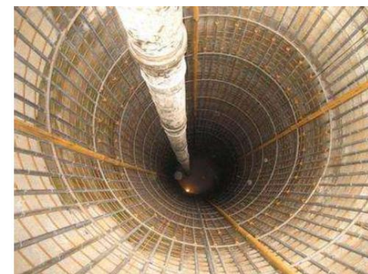
人工挖孔桩安装钢筋笼
